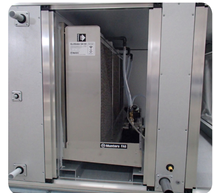
Пример установки FA6 в секцию системы обработки воздуха.
